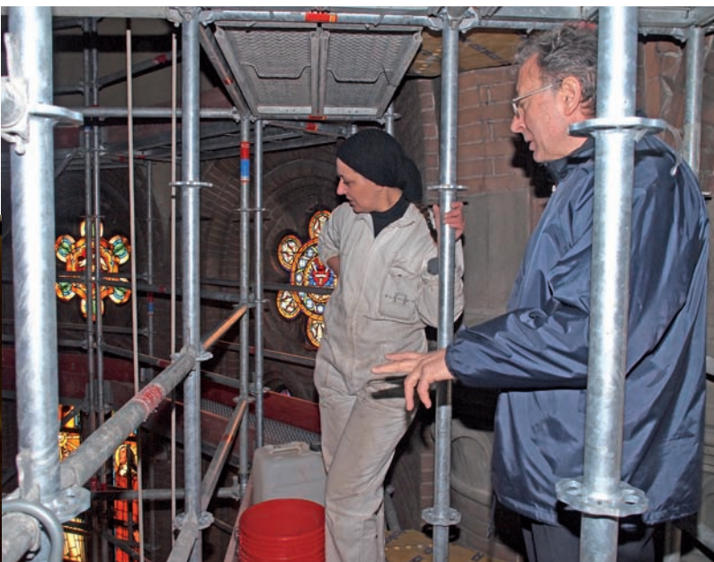
Il Parroco, Don Antonio Rota, segue i lavori di restauro
